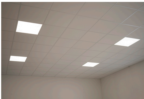
BEL-33919 monterad direkt i bärverkstak.
